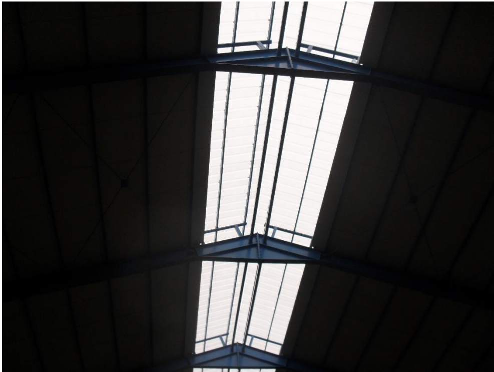
LUMINATOR REALIZAT DIN POLICARBONAT
