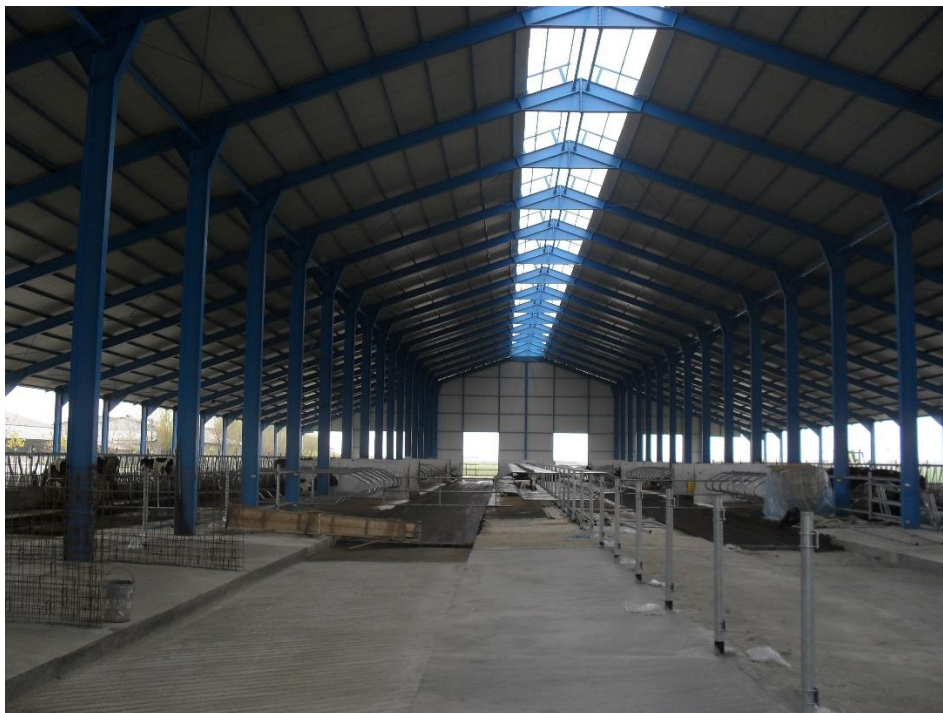
ANSAMBLU HALA - MONTAJ GRILAJE TARC
