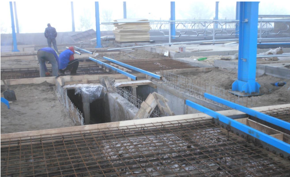
ARMARE SI COFRARE CANAL COLECTOR DEJECTII
