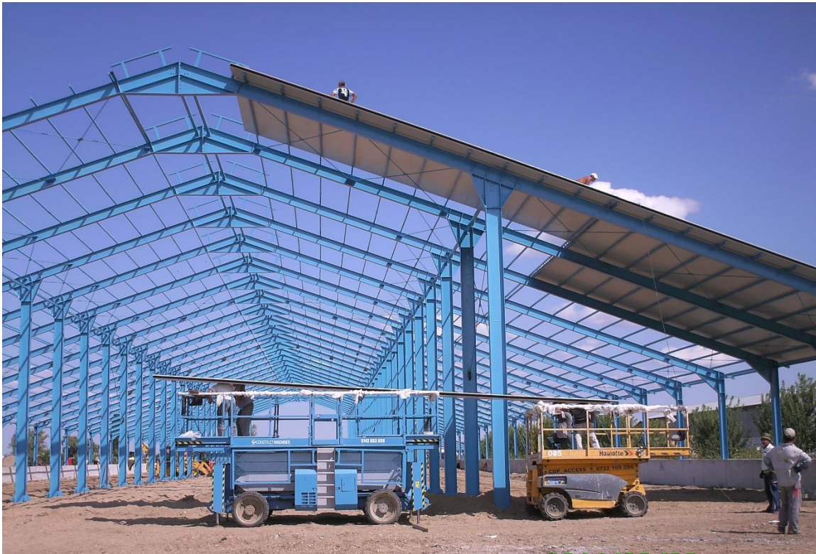
↑Montaj acoperis din panouri sandwich↓
