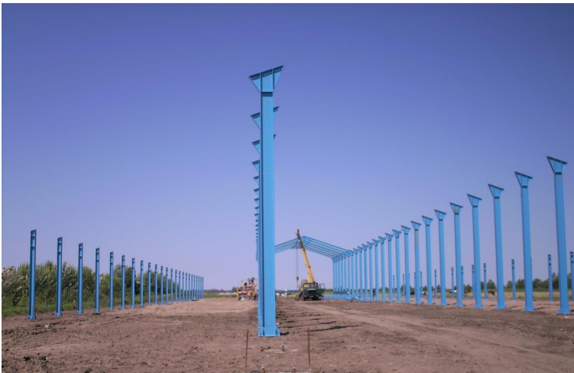
↑Compactarea terenului si montarea stalpilor↓
