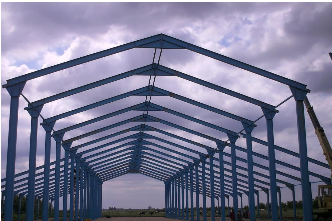
Structura metalica dupa montarea fermelor
