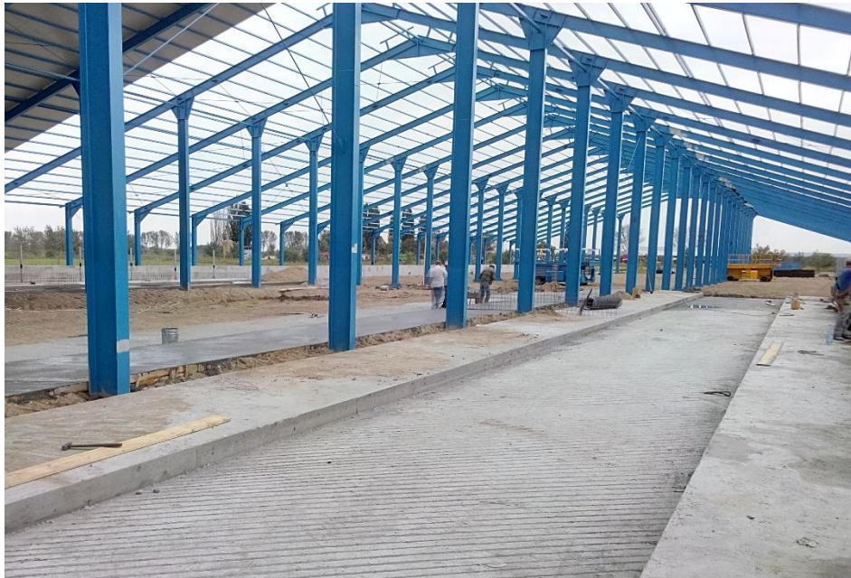
BETONARE ALEE RACLOR SI SPATIU ODIHNA
