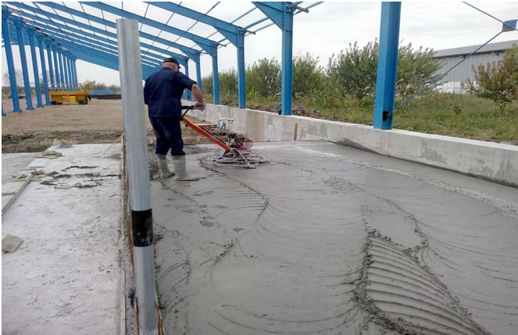
BETONARE ELICOPTERIZATA ALEE FURAJARE
