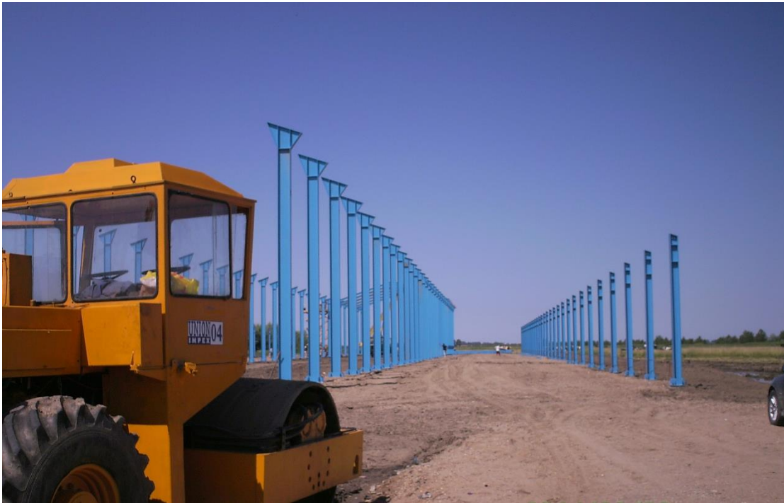
↑Compactarea terenului si montarea stalpilor↓
