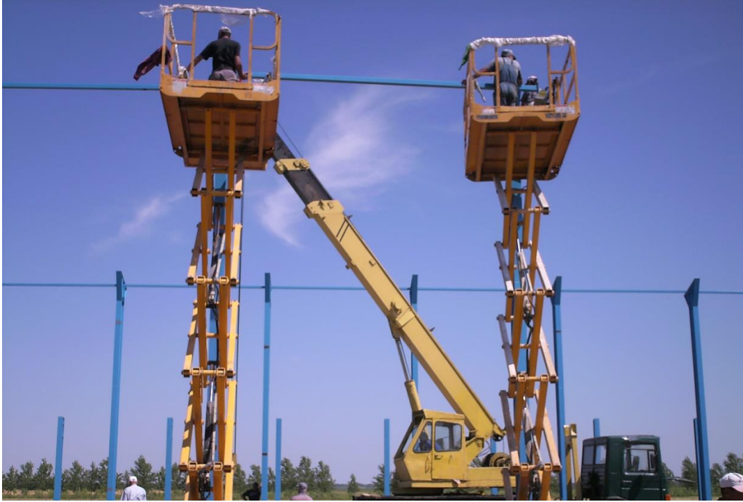
Montarea grinzilor longitudinale cu ajutorul nacelelor
