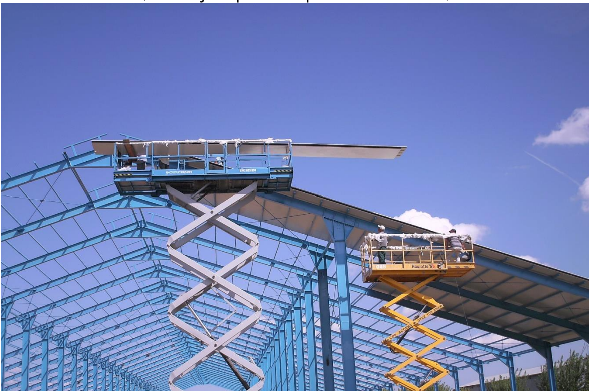
↑Montaj acoperis din panouri sandwich↓
