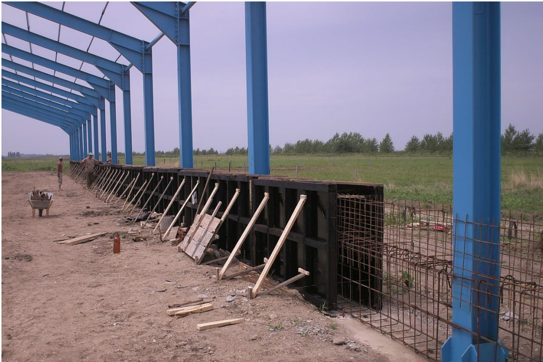
Cofraj si armare grinda perimetrala
